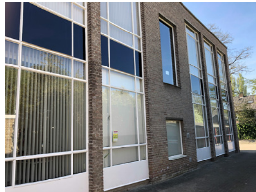
Noordgevel (2020, afdeling Erfgoed).
