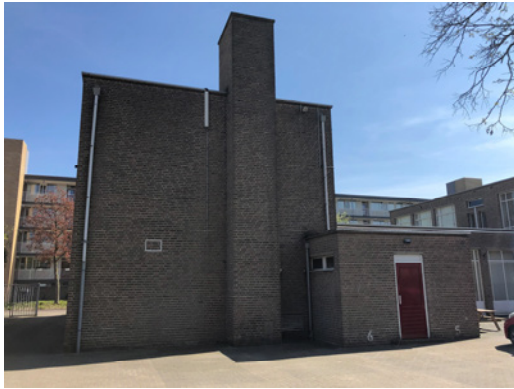
Noordwestelijke kopgevel (2020, afdeling Erfgoed).
